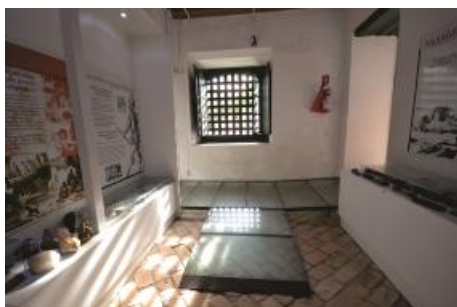
Fig. 8 Rampa interna em aço e vidro temperado. Fonte: os autores, 2016
