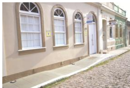
Fig. 13 Adaptação no passeio público. Fonte: os autores, 2016
