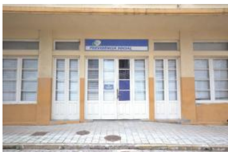
Fig. 10 Adaptação no passeio público. Fonte: os autores, 2016
