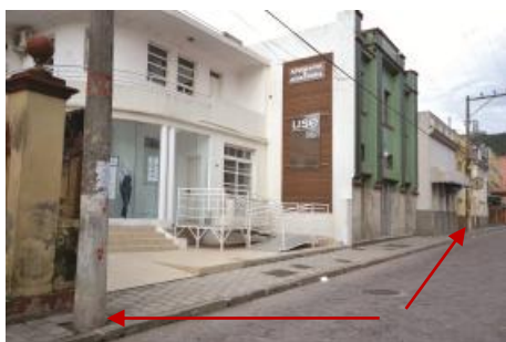
Fig. 16 Postes que impedem a passagem dos transeuntes. Fonte: os autores, 2016
