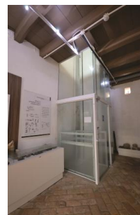
Fig. 9 Elevador interno. Fonte: os autores, 2016
