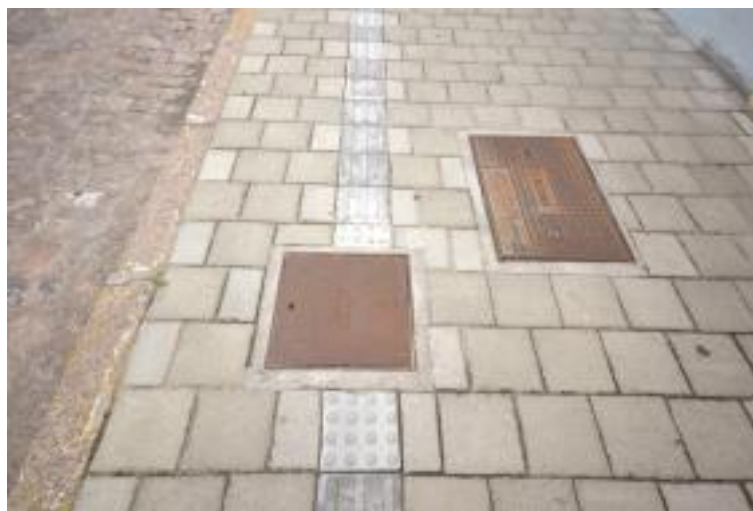
Fig. 20 Piso podotátil utilizado incorretamente. Fonte: os autores, 2016
