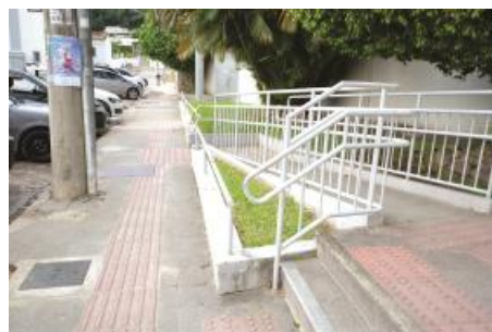
Fig. 11 Rampa de acesso a agência bancária. Fonte: os autores, 2016
